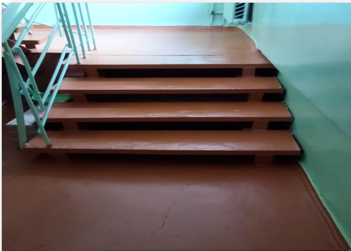
Фото 11. Лестница (внутри здания)
